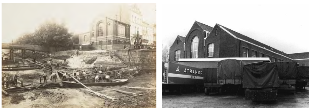
Links: de nieuwe Verlorenkostbrug in aanbouw in 1898, met op de achtergrond het eerste atelier Baertsoen (Beeldbank Gent). Rechts: nog bestaande gebouwen van de SA Baertsoen-Buyse aan de Dendermondsesteenweg in Gent (bron: < https://inventaris.onroerenderfgoed.be/erfgoedobjecten/18214 >.)
